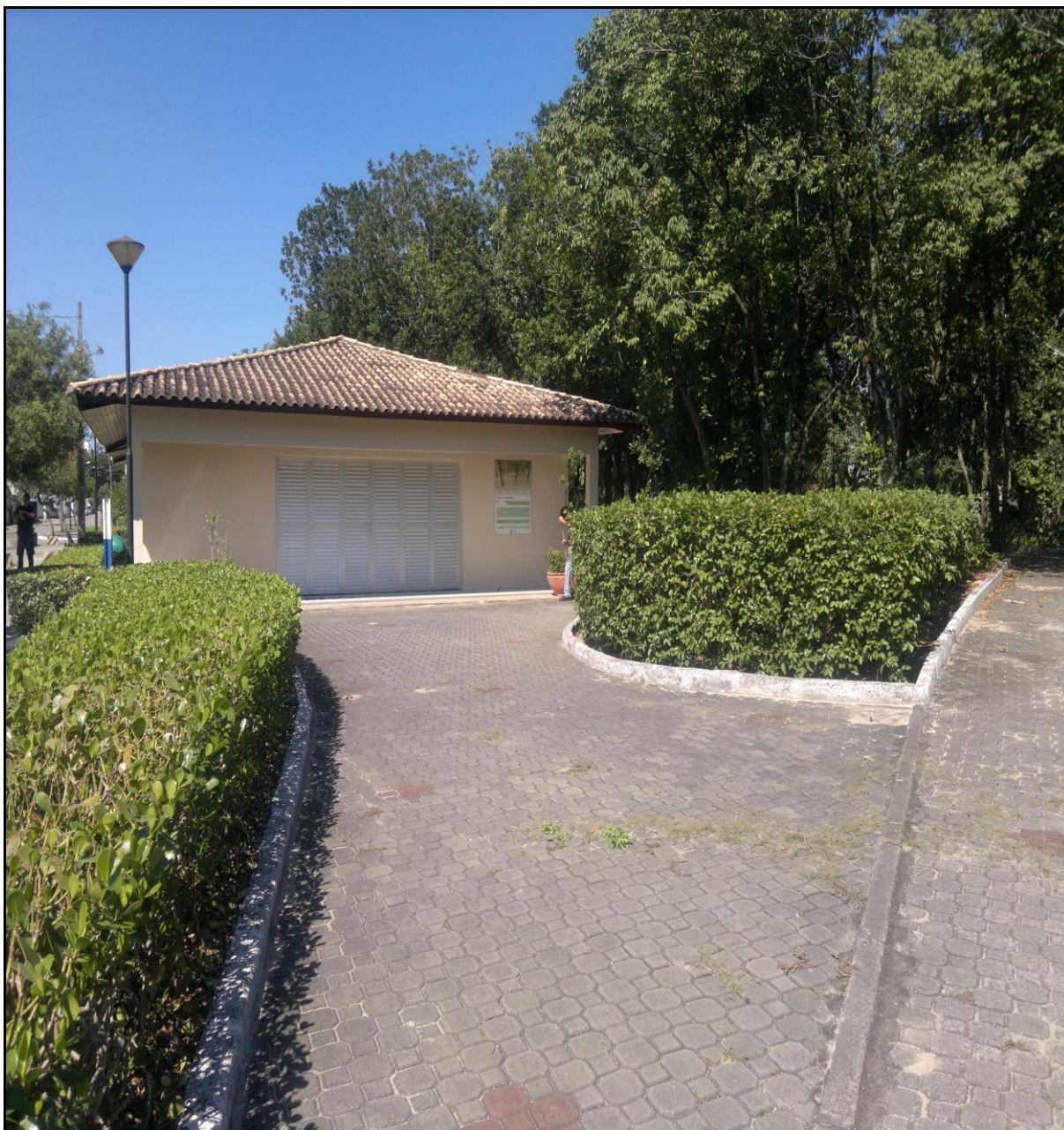
FOTO 03: Acesso ao prédio que abriga o CEA Mata da Praia e o auditório (em perspectiva), Parque Padre Alfonso Pastore.
