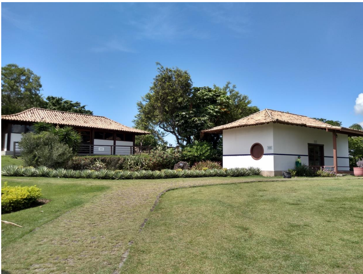
FOTO 02: Prédio da Administração e CEA Parque Pedra da Cebola. Fonte: GONÇALVES, nov. 2020.
